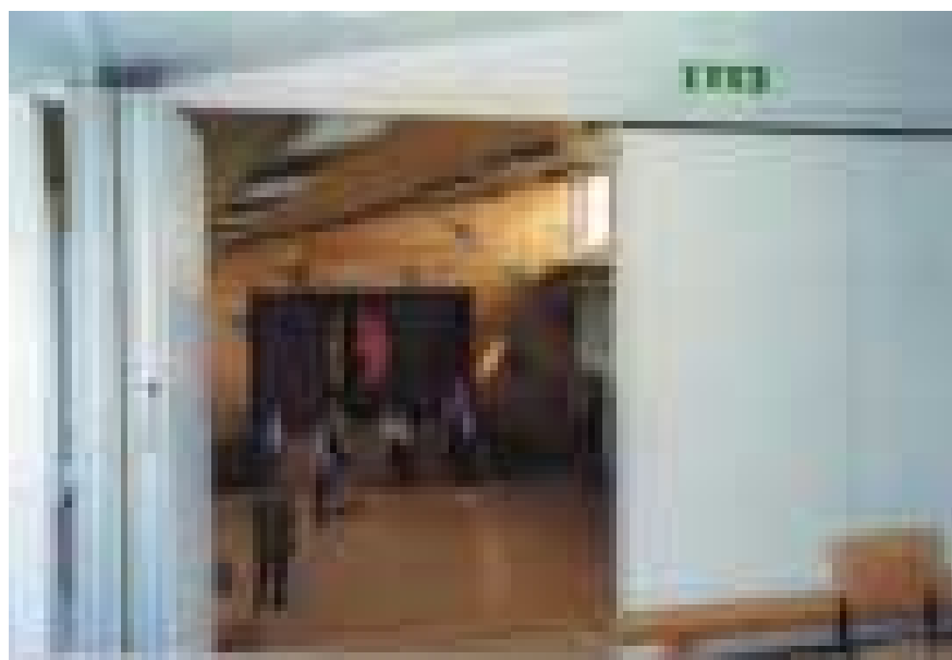
Foldevæg mellem musiklokale og festsal vil sjældent medføre støjgener. (Fuglsanggårdskolen, Lyngby-Tårnbæk Kommune).
